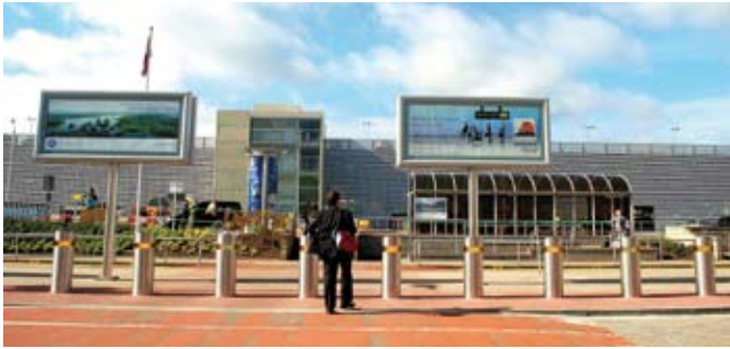
The open design with wide support distances was achieved with a systematised supporting structure construction | Die offene Bauform mit weiten Stützenabständen wird durch eine systematisierte Tragwerkkonstruktion erreicht
