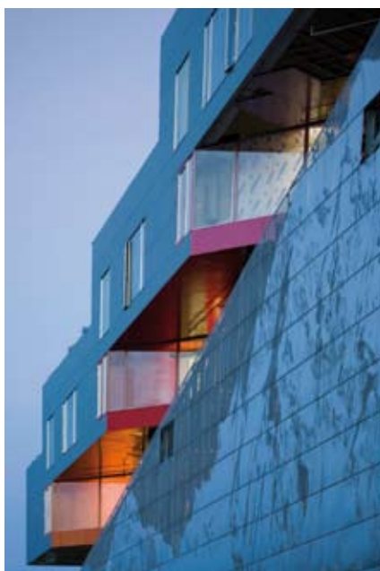
Die Symbiose aus Wohnen und Parken führte zu einem außergewöhnlichen architektonischem Projekt.
